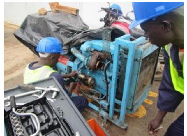
写真3 電気・機械設備の維持管理研修(ウガンダ)
