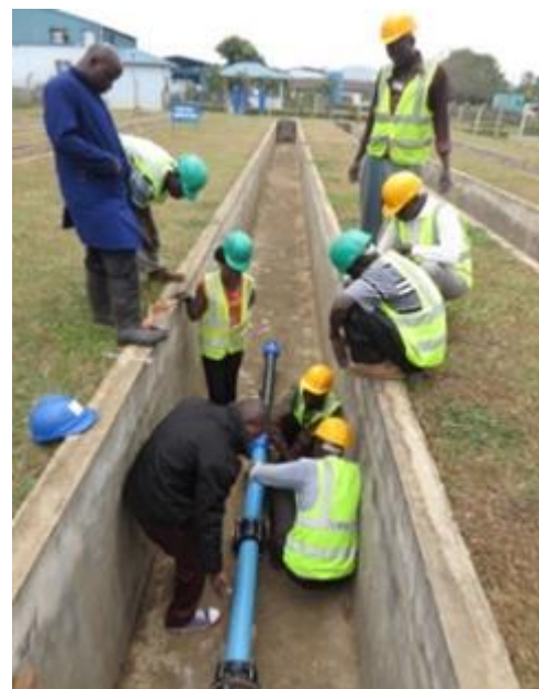
写真4 デモンストレーションサイトでの管路接続研修(ウガンダ)
